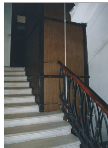
Esempio di inserimento dell'impianto ascensore nella tromba delle scale, mediante riduzione della scala e taglio di scalini.
