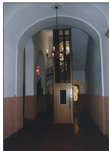
Vano ascensore installato in mezzo al passo carraio che conduce alla corte.
