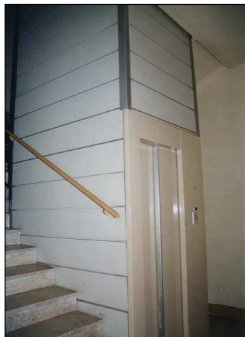
Esempio di inserimento dell'impianto ascensore nella tromba delle scale, mediante riduzione della scala e taglio di scalini.
