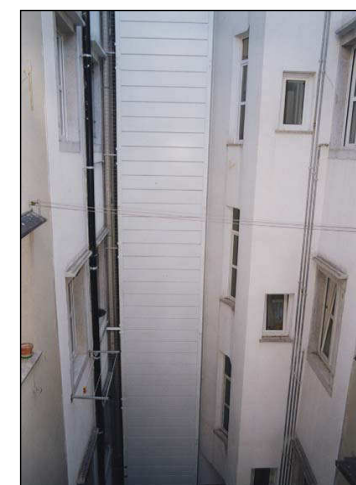
Esempio di impianto ascensore installato esternamente all'edificio, nella corte.
