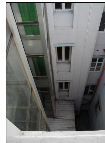
Esempi di ascensori realizzati nello spazio libero della corte
