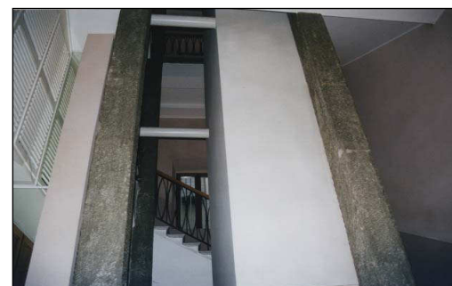
Inserimento di un ascensore tra i pilastri della scala a tre rampe ortogonali.
