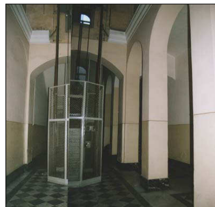
Vano ascensore installato in mezzo al passo carraio che conduce alla corte.
