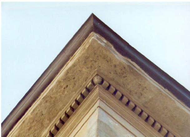
Dettaglio di cornice monocromatica in cui sono chiaramente visibili tutte le modanature, in particolare i dentelli con la pigna d'angolo secondo la tradizione del coronamento classico greco. Si noti il trattamento dell'intonaco ad imitazione della pietra.
