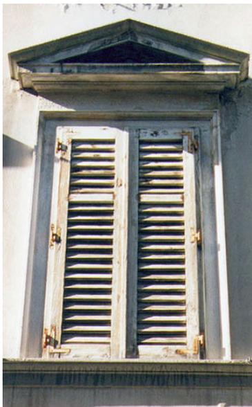
Persiana in legno verniciato a due ante bipartite con lamelle fisse. Ciascun battente è incernierato in tre punti al telaio fisso sovrapposto alla cornice della finestra. La posizione del traverso di ripartizione dell'anta è a circa un terzo dell'altezza.
