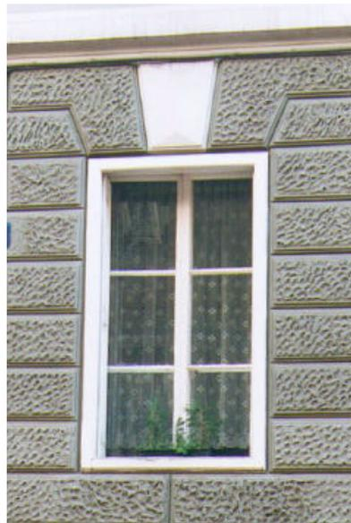
Apertura delimitata dalle bugne rustiche del basamento realizzate in intonaco. Il bugnato ripiega in corrispondenza dell'architrave con chiave di volta a diamante in risalto (e differenziata dalle bugne rustiche anche dal trattamento cromatico). Internamente l'apertura è rifinita da una semplice cornice in legno.
