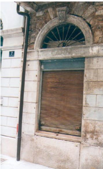
Saracinesca in ferro per una finestra al piano terra. Il sopraffine circolare è protetto da una rosta in ferro verniciato
