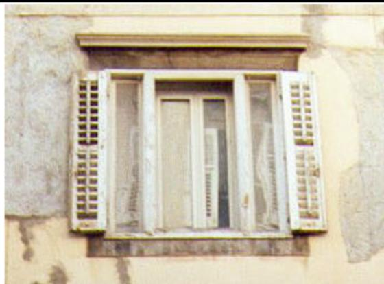
Infisso tripartito con due battenti centrali e due ante apribili laterali. I battenti centrali sono stati sostituiti con profilati in alluminio pre-verniciato.
