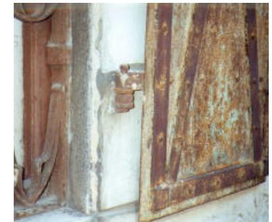
Particolare della cerniera con il perno infisso nella cornice in pietra e vista dell'interno del portellone con gli irrigidimenti in piattine di ferro chiodate.
