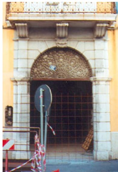
Portale inquadrato in pannello bugnato sormontato dalle mensole del poggiolo, di cui quella centrale in chiave dell'arco e quelle laterali in prosecuzione delle paraste bugnate che emergono dal piano. Si noti il lieve aggetto della cornice all'imposta dell'arco.
