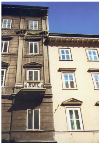
Rivestimento in bugne piane a fasce alternate di altezza variabile, scandito negli avancorpi laterali da un doppio ordine di lesene riquadrate: di ordine gigante per secondo e terzo piano terzo piano e di altezza ridotta per il piano attico. Il trattamento cromatico è ad imitazione della pietra con differenze di tono per fondi e rilievi.
