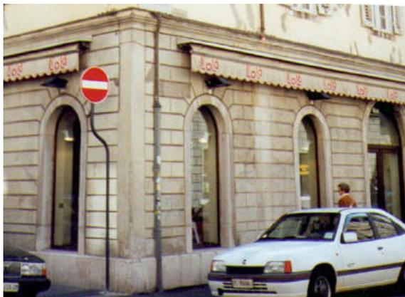
Rivestimento in intonaco tinteggiato lavorato a bugne piane lisce, con giunti convergenti in corrispondenza delle cornici ad arco delle aperture e con lesene angolari lisce sottolivello ai cantonali. Il bugnato si innesta su una zoccolatura in pietra naturale di circa 60 cm di altezza e termina in corrispondenza della fascia marcapiano modanata che separa il piano terra dal primo piano.
