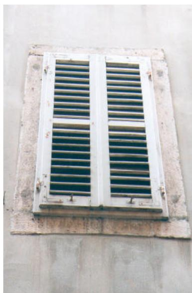
Persiana rettangolare in legno verniciato a due battenti bipartiti con lamelle fisse. Il traverso è posto a metà dell'altezza dell'anta incernierata in due punti al telaio fisso.
