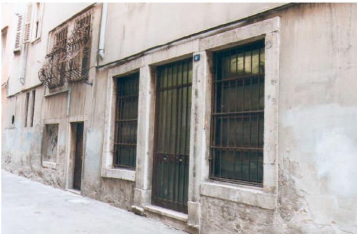
Rivestimento del basamento in intonaco liscio tinteggiato. Il trattamento superficiale è in continuità con il rivestimento dei piani superiori e parte dalla linea di terra.
