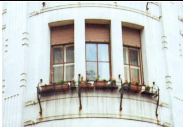
Apertura tripartita da pilastrini a piani lisci complanari al rivestimento liscio della facciata. Inferiormente l'apertura è delimitata da una fascia marcapiano dell'altezza del parapetto arricchita dall'inserimento di un porta fioriera in ferro battuto.
