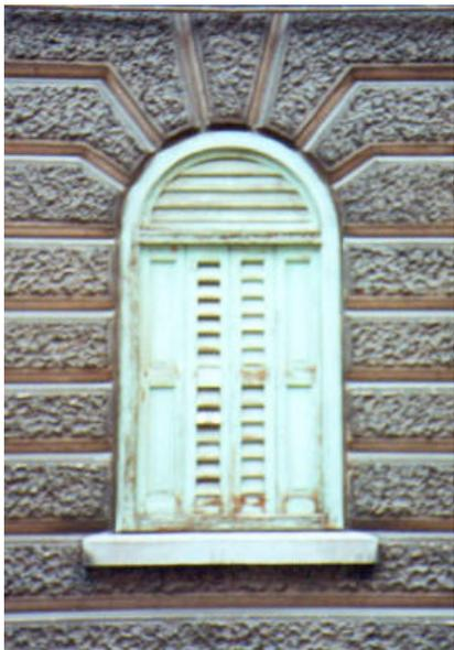
Persiana in legno verniciato di un'apertura ad arco, composta da quattro ante mobili rettangolari e da un sopra luce semicircolare fisso con specchiatura unica le lamelle orientate.
