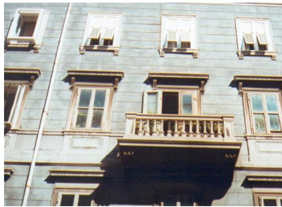
Fondo in intonaco liscio tintecciato lavorato a fasce orizzontali. Il rivestimento è interrotto dall'alta fascia marcapiano del secondo piano che comprende anche i pannelli sottofinestra.
