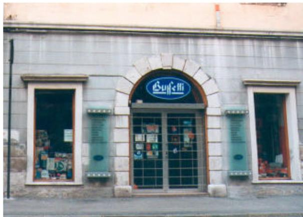
Basamento in intonaco con trattamento cromatico differenziato rispetto al rivestimento dei piani superiori. Il basamento listato liscio si innesta sulla zoccolatura in intonaco a forte spessore di circa 30 cm di altezza e termina in corrispondenza della fascia marcapiano che separa il piano terra dal primo piano.
