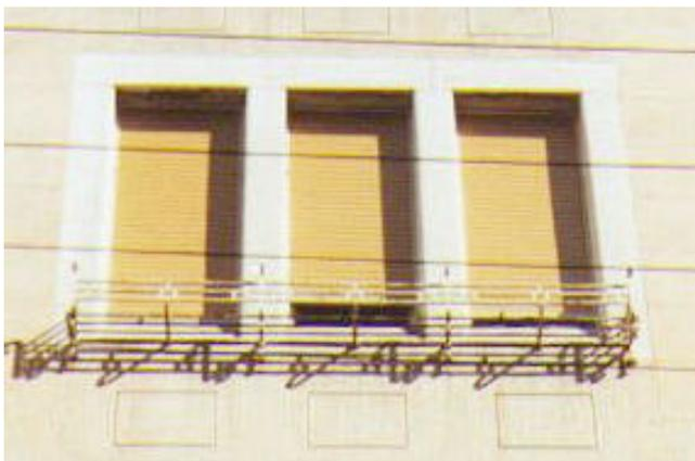
Cornice che delimita tre fori affiancati e separati da pilastrini. La cornice rettilinea è a piani lisci a filo con il paramento esterno listato. Il lato inferiore delle aperture è dotato di portafioriera in ferro battuto verniciato. Sempre inferiormente ai vani, il paramento è decorato con un motivo e riquadri che definisce un pannello sottofinestra per ciascun vano..
