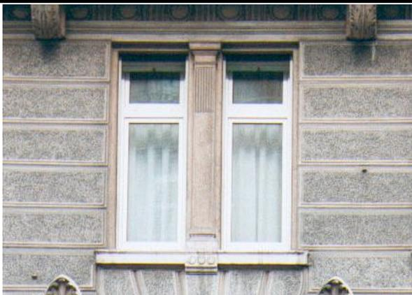
Cornice monocromatica di un'apertura bipartita con pilastrino dorico centrale. La cornice a piani lisci, sottoposta rispetto al piano del bugnato rustico del paramento e del pilastrino, riquadra ciascun foro su tre lati. La parte inferiore dell'apertura è delimitata da un davanzale rettilineo a piani lisci con gocciolatoio e con elemento decorato in lieve aggetto in corrispondenza del pilastrino centrale.
