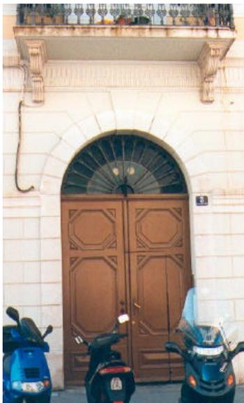
Portale in pietra a conci regolari con elemento di chiave lievemente aggettante. I giunti sono in continuità con quelli del rivestimento sottoposto in intonaco bugnato liscio del basamento.
