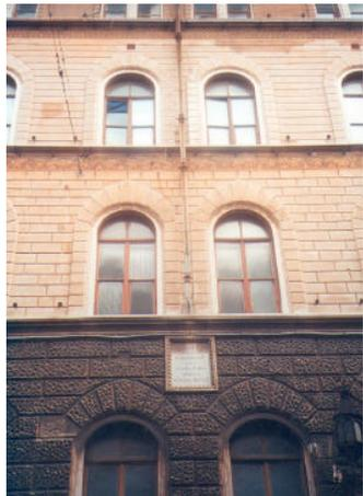
Rivestimento bugnato in intonaco differenziato per i vani piani. Il basamento è trattato a bugnato rustico, il primo livello a bugne piane scannellate e il secondo a fasce orizzontali; il piano attico ha un rivestimento in intonaco liscio. I marcapiani alla quota bancale delle finestre sono arricchiti da fregi.
