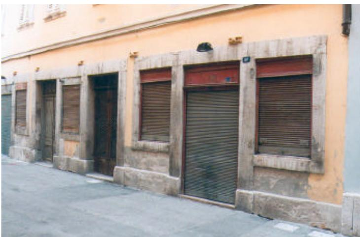
Rivestimento del basamento in intonaco liscio tinteggiato. Il trattamento superficiale è in continuità con il rivestimento dei piani superiori e si innesta sulla zoccolatura, anch'essa in intonaco..
