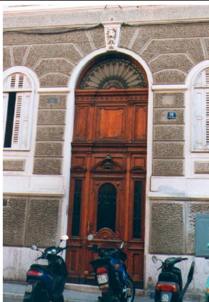
Portone in legno naturale con rosta in ferro e vetro. Il portone suddiviso in due settori verticali, per la notevole altezza, ha le specchiature riccamente decorate. La parte centrale è scandita da forature chiuse da inferriate con vetro sormontate da timpani curvilinei.
