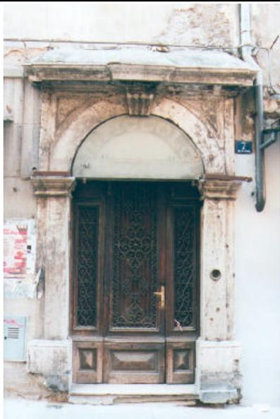
Portone in legno con inferriate. Le cornici lignee delle ante racchiudono pannelli in ferro a volute. La parte inferiore, di altezza corrispondente alla base dei piedritti lapidei del portale, presenta specchiature bugnate. L'anta a battente centrale si apre verso l'interno da destra verso sinistra.
