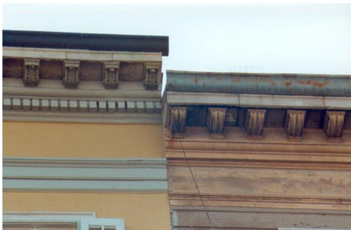
Cornicioni con fasce sottocornice modanate. La sporgenza delle lastre sottocornice è assicurata da una serie ravvicinata di modiglioni.
