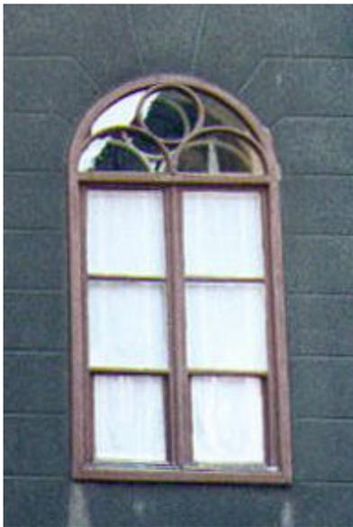
Serramento in legno con due ante mobili tripartite e sopra luce semicircolare fisso. La parte inferiore di ciascuna anta è apribile a coulisse.
