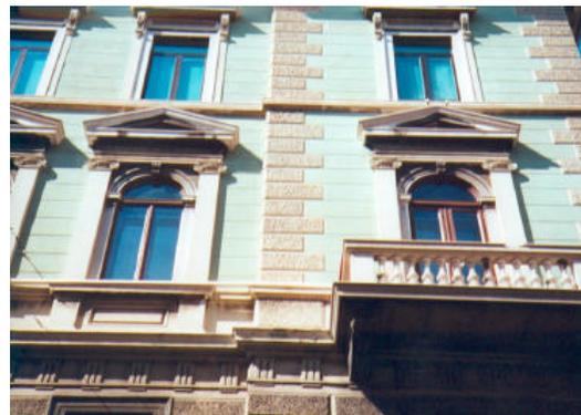
Fondo in intonaco liscio listato. Gli avancorpi laterali sono definiti da ammorsature in bugne rustiche (anteridi) tintecciato ad imitazione della pietra.
