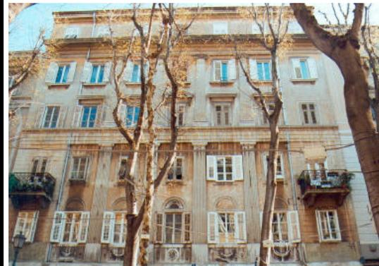
Le tre campate centrali sono scandite da un doppio ordine gigante di ordini sovrapposti (dorico e ionico). La trabeazione del primo ordine e le due campate laterali del primo e del secondo piano, sono trattate con bugnato liscio a fasce continue aggettanti dal paramento..
