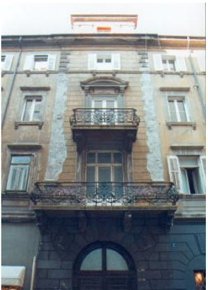
Sul fondo in intonaco liscio tintecciato a calce, emerge l'avancorpo centrale listato, definito da ammorsature laterali in bugne rustiche (anteridi). Cornici marcapiano separano il primo ed il secondo piano dal basamento e dal piano attico. Le anteridi hanno trattamento cromatico differenziato da quello dei fondi.
