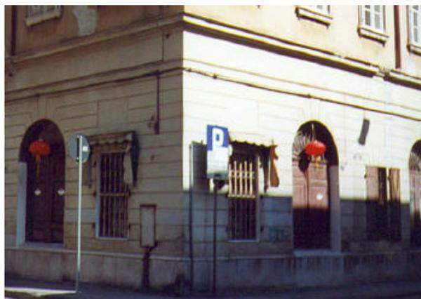
Rivestimento in intonaco liscio listato con giunti convergenti in corrispondenza dei vani di apertura ad arco e riquadri leggermente sotto livello in corrispondenza delle finestre architravate. Il basamento listato si innesta su una zoccolatura in pietra naturale con toro di coronamento di circa 60 cm di altezza e termina in corrispondenza di un'alta fascia marcapiano che separa il piano terra dal primo piano.
