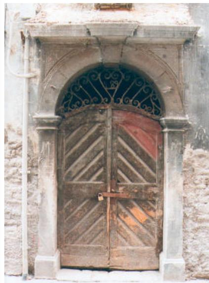
Vista esterna di portone a due ante con profilo superiore curvilineo in legno verniciato. Le specchiature sono a doghe larghe inclinate a 45°. La rosta in ferro battuto è composta di elementi sagomati ad "S" con iscrizione della data in posizione centrale.
