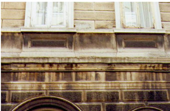
Rivestimento bugnato in intonaco per piano terra e primo piano con trattamenti superficiali ad imitazione della pietra. Il rivestimento a bugne smussate rustiche del piano terra si interrompe in corrispondenza della fascia marcapiano modanata del primo piano che risulta rivestito da bugne scannellate piane.
