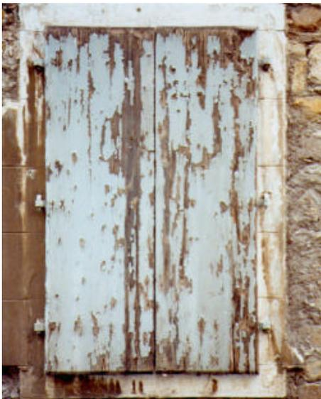
Cornice rettilinea in pietra con gli stipiti scanalati in corrispondenza dei giunti del paramento listato. La cornice è intonacata e tinteggiata in continuità con il paramento.
