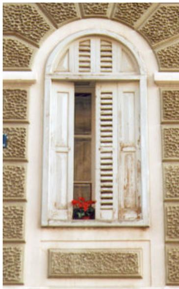
Cornice semicircolare in intonaco liscio con pannello sottofinestra. Il piano della cornice è sottoposto al filo del paramento bugnato. Il pannello sottofinestra è riquadrato con elemento centrale lavorato a bugna rustica.
