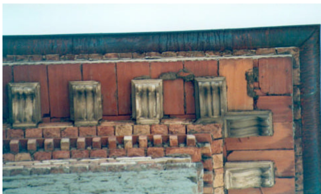
Dettaglio di cornice al rustico in cui sono chiaramente visibili gli elementi costituenti: mensola in forati e piastrelle sostenute da modiglioni in pietra (si noti l'elemento monolitico d'angolo), filari di mattoni sottomensola con spigoli arrotondati ed elementi sagomati a dentelli.
