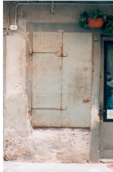
Portellone in ferro a due battenti con due bandelle per la sola anta sinistra.
