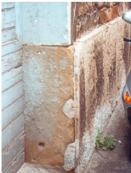
Zoccolatura a riquadri di circa cm 80 di altezza, realizzata in intonaco con finitura ad imitazione della pietra.
