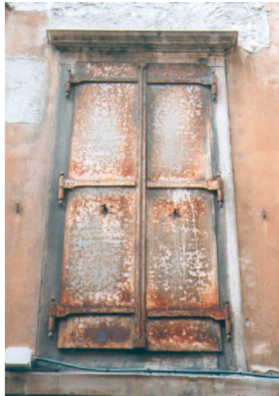
Portellone in ferro a due battenti e due bandelle per anta.
