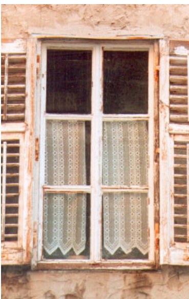
Infisso in legno verniciato a due ante apribili verso l'interno. Ciascuna anta è suddivisa in tre parti vetrate fisse. Il telaio fisso della finestra costituisce anche l'alloggiamento per le ante della persiana.
