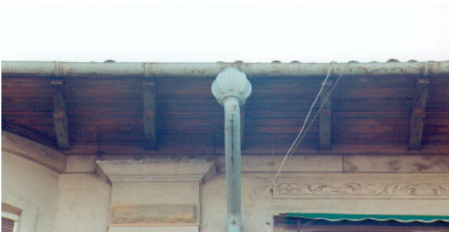
Cornicione in legno con mensole a sporgere e tavolato sovrapposto. Si noti che il legno è lasciato nel suo colore naturale e che gli elementi impiantistici soddisfano anche l'esigenza estetica.
