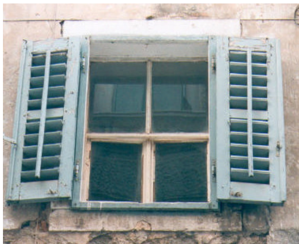
Infisso semplice costituito da una metà superiore fissa e dalla parte inferiore apribile a due battenti.
