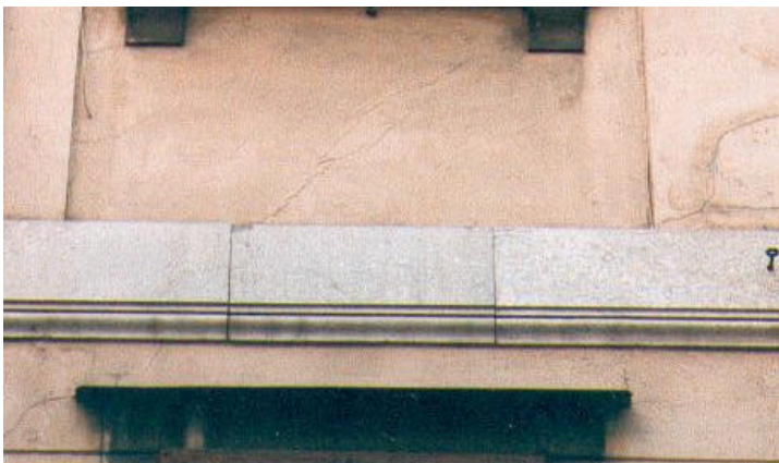
Cornice marcapiano lapidea a piani lisci e con bordi lievemente modanati, impostata alla quota dell'impalcato.
