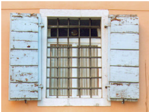
Portellone in legno verniciato; il tavolato interno è costituito da cinque tavole per ciascuna anta.
