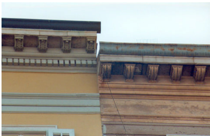
Cornicioni con fasce sottocornice modanate. La sporgenza delle lastre sottocornice è assicurata da una serie ravvicinata di modiglioni.
