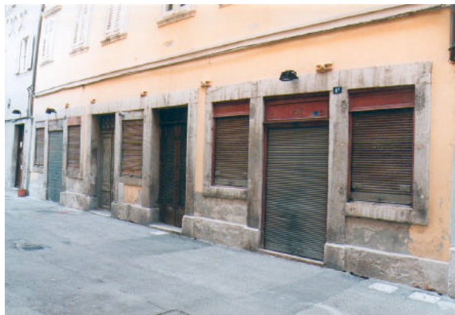
Saracinesche in ferro per porte e finestre architravate al piano terra
