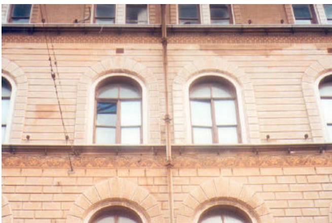
Fasce marcapiano decorata in pietra e in intonaco tinteggiato. La cornice superiore in pietra, posta alla quota bancale delle finestre e sostenuta da elementi in ferro, costituisce l'elemento di protezione per la fascia sottostante decorata con fregi.
