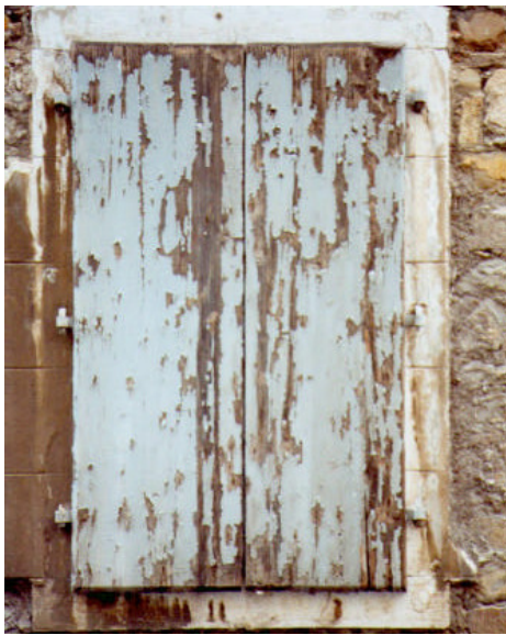
Portellone in legno verniciato, sostenuto da un sistema di tre cerniere per ciascuna anta.
