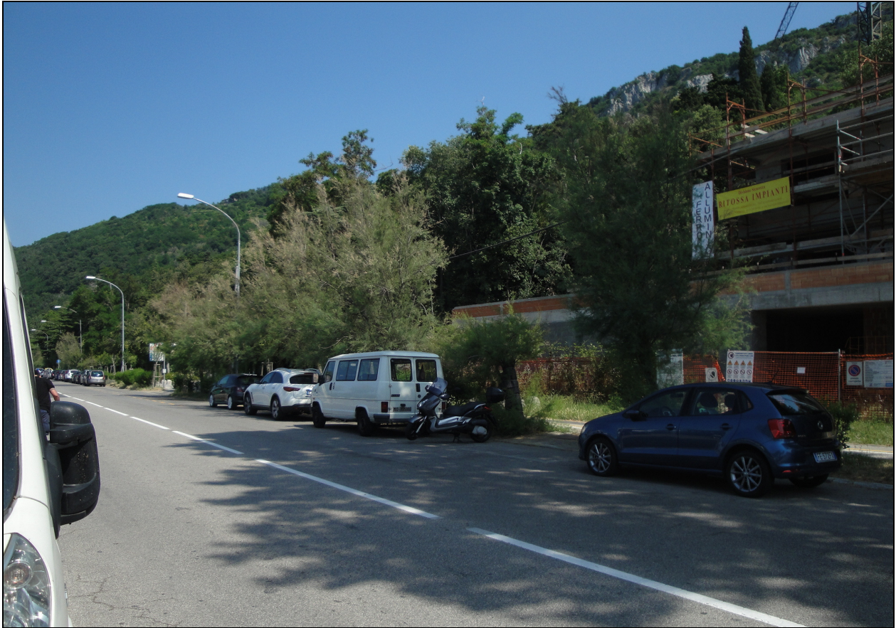
P.d.V. 1 - Vista laterale dal marciapiede opposto all'altezza dell'ultimo dei Topolini. Il cantiere a dx è interno al PAC.
