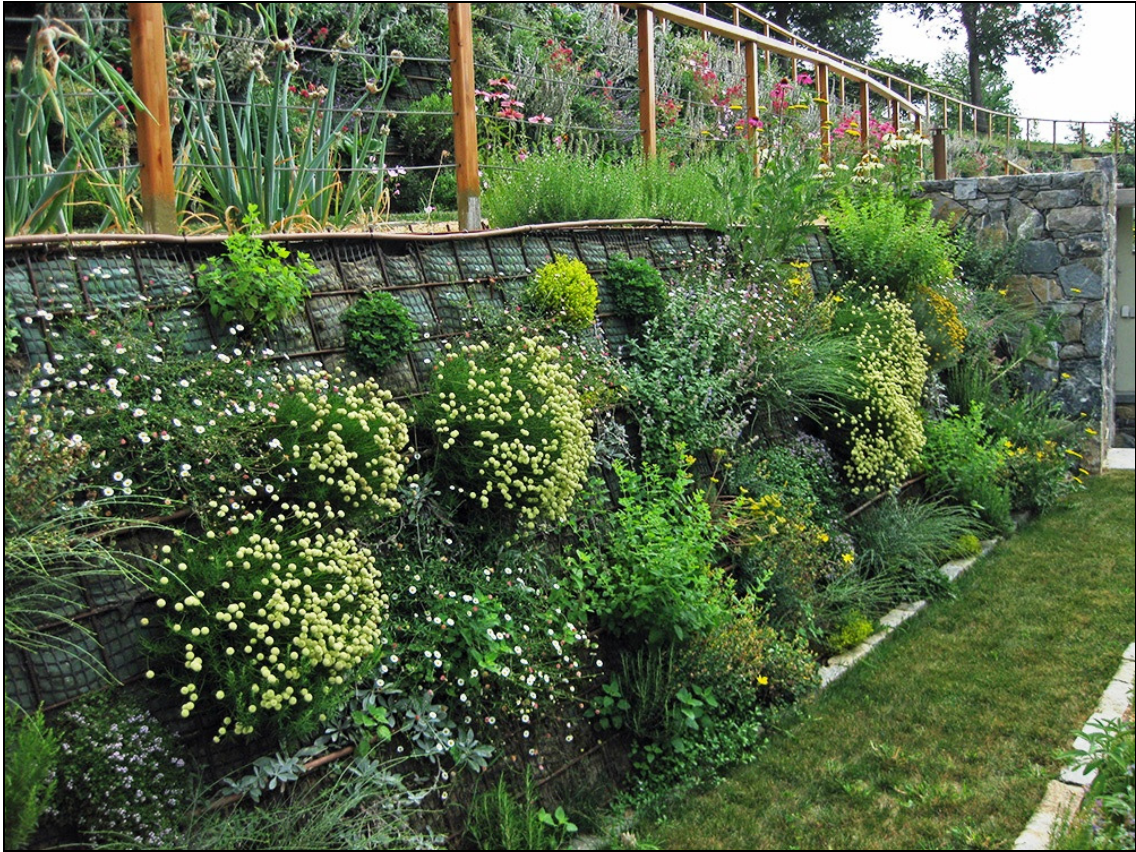
Terra armata in fase di rinverdimento
