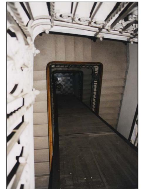
Secondo il sistema STIGLER, la cabina costruita in legno o in ferro, è racchiusa in un telaio di ferro contenente gli apparecchi di sicurezza ed i pattini di guida. Gli inserimenti nei pozzi delle scale sono rispettosi della tipologia della scala.
