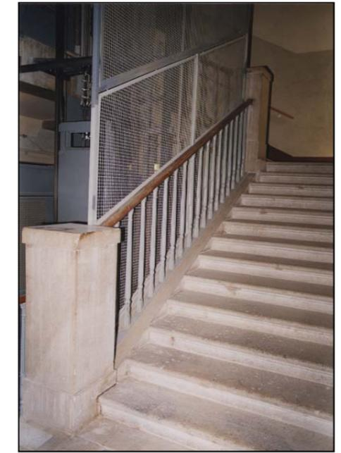
Le scale a tre rampe ortogonali, presentano un ampio pozzo centrale vuoto. Ciò ha permesso di inserire l'impianto dell'ascensore senza intaccare la struttura delle rampe né provocare il tagli degli scalini.
