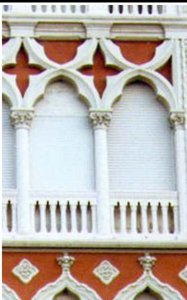
Persiana avvolgibile in legno verniciato. Nell'apertura di destra la parte superiore della persiana è fissa..
