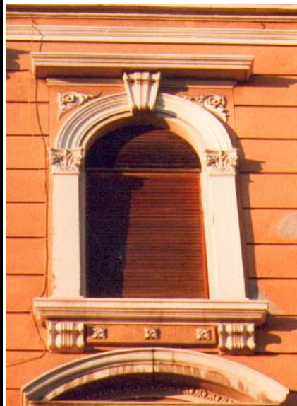
Persiana avvolgibile in legno naturale. La persiana risulta suddivisa in due parti: una semicircolare fissa e l'altra rettangolare avvolgibile con sistema basculante
