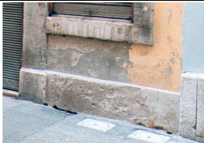
Zoccolatura a piani lisci in intonaco a forte spessore di circa cm 40 di altezza, inserita tra i piedritti degli stipiti delle aperture a piano terra realizzati in pietra.
