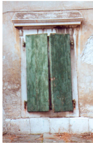
Portellone in legno verniciato, sostenuto da un sistema di due cerniere per ogni anta.
