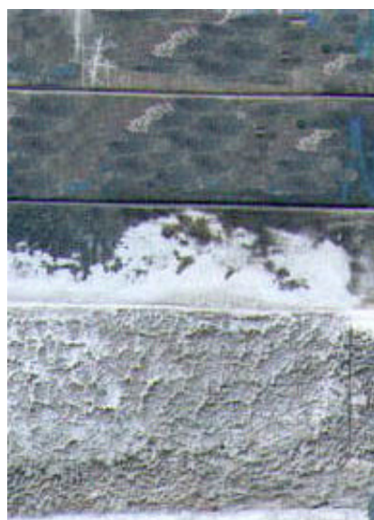
Zoccolatura in intonaco di circa cm 60 di altezza, con finitura a rustico ad imitazione della pietra.
