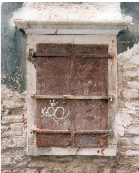
Portellone in ferro a due battenti e due bandelle per anta, con sbarre di sicurezza esterne.
