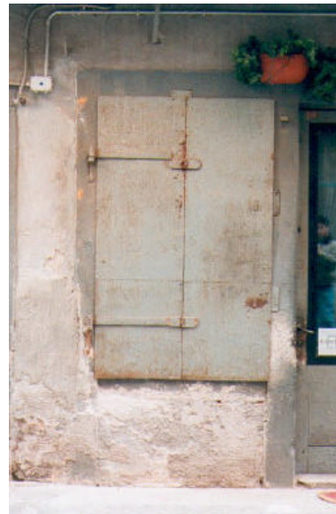
Portellone in ferro a due battenti con due bandelle per la sola anta sinistra.
