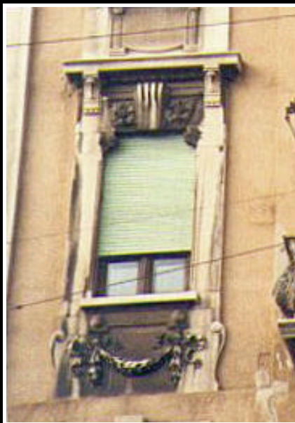
Persiana avvolgibile in legno verniciato con telaio fisso.
